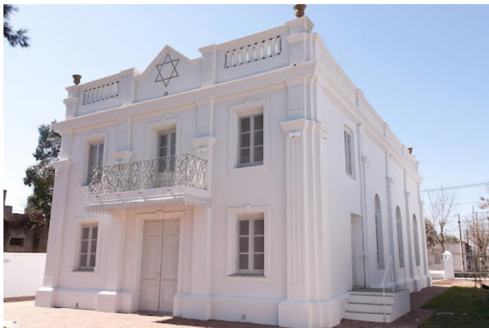
La sinagoga de Brener, antes y después de la restauración.
